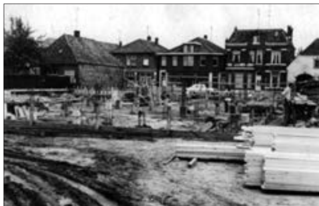
De fundering maken voor de nieuwbouw.
