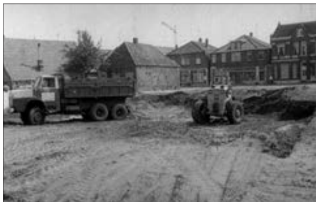
De bouwput uitgraven voor de nieuwbouw.
